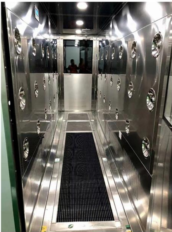
鞋底清洗机风淋室
